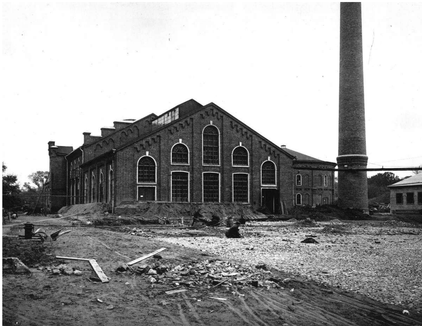
Аппаратное здание Московского газового завода
