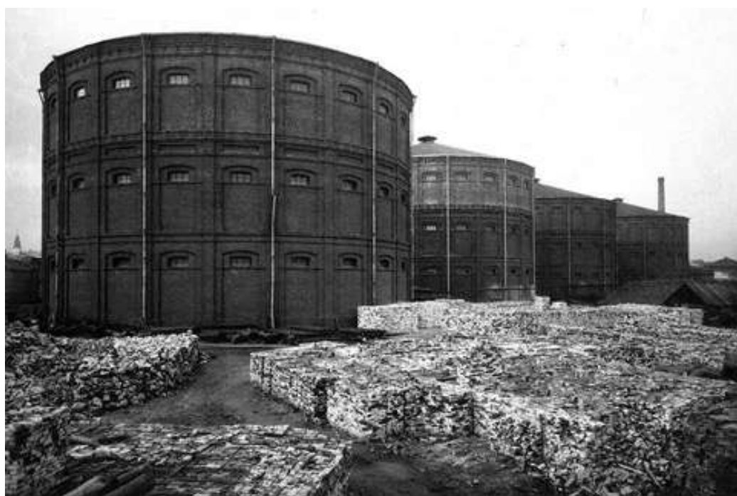
Газгольдеры Московского газового завода
